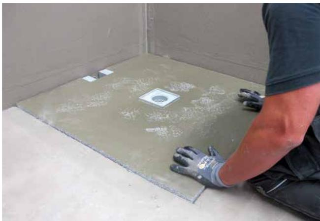
3 Einsetzen des Poresta-Duschelements in das frische Kleberbett. Nach dem Eindichten des Elements mit Sopro DichtSchlämme Flex 1-K kann mit der Fliesenverlegung begonnen werden.
