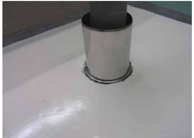
**4** Mit Sopro PU-FlächenDicht eingedichtetes Hüllrohr.
