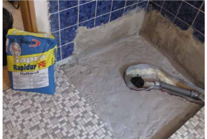
2 Herstellen einer planebenen Verlegefläche mit Sopro Rapdidur® FE FließEstrich für die sichere, vollflächige Verlegung des Duschelements.
