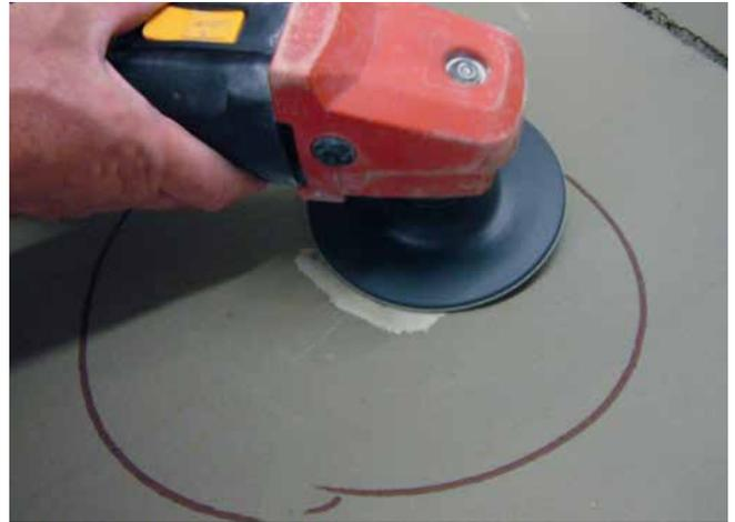
Anschleifen der Schnittkanten zur Herstellung einer Übergangszone.
