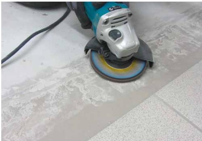
3 Anschleifen der Abdichtungsebene und Entfernen der Kleberreste mittels kleiner Flex.
