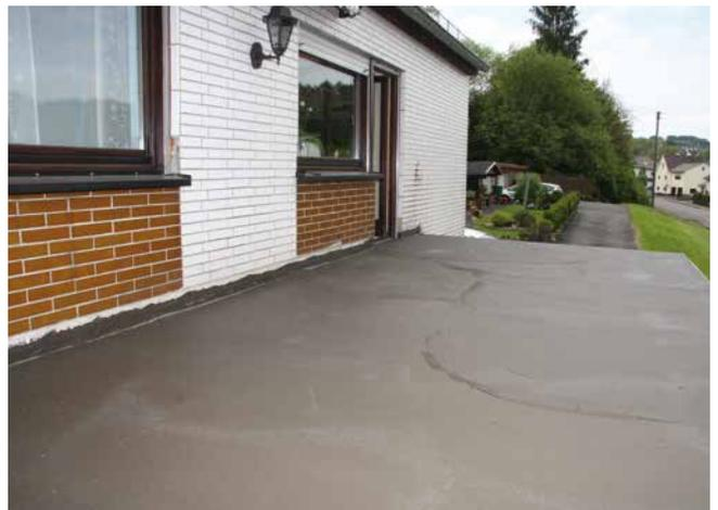
4 Abgedichtete Balkonfläche mit Sopro DichtSchlämme Flex in zwei Arbeitsgängen mit einer gesamt Mindestschichtstärke von 2 mm.
