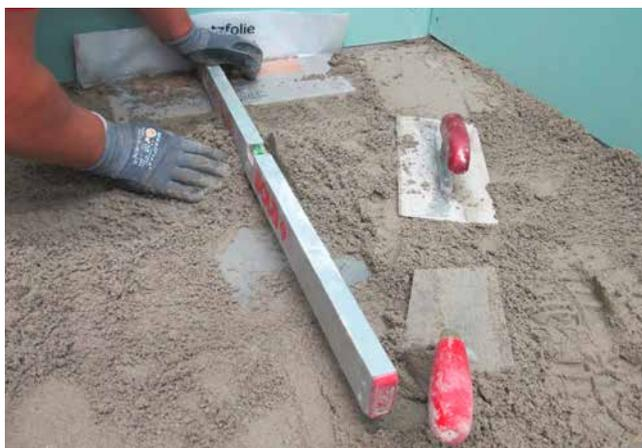
2 Einbau des Bodenablaufelements in den Estrich mit Sopro Rapidur® M1/Sopro Rapidur® M5 mit entsprechendem Gefälle.
