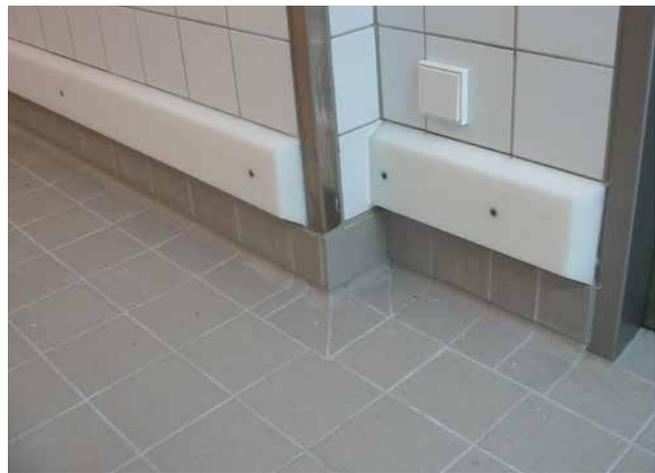
Ausgeführtes Sockeldetail mit Prallschutz.
