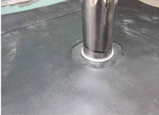
**1** Erstes Hüllrohr mit Flansch und angeklebter Bahnabdichtung (System Wolfen) oberhalb der Dämmlage.
