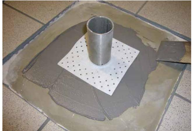
**2** Die Rohrdurchdringung wird durch eine Dichtmanschette eingefasst. Diese wird in das Verbundabdichtungsmaterial eingearbeitet.
