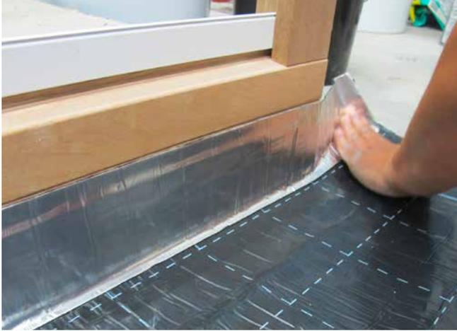
1 Bahnabdichtung mit SoproThe Abschlussband Aluminium am Türelement.
