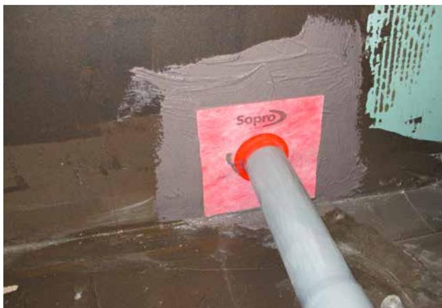
Die Sopro AEB® Wandmanschette 130 wird in die flüssig zu verarbeitende Verbundabdichtungsmasse eingearbeitet.
