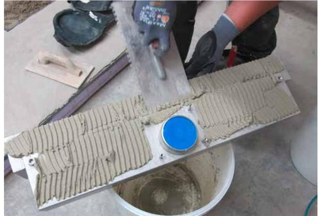
2 Abspachteln der Rinnenrückseite mit Fliesenkleber (Sopro's No.1 S1 Flexkleber) zur Herstellung eines guten Haftverbundes zum Estrichmörtel.
