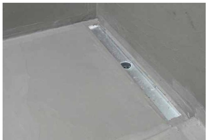
6 Abgedichtete Duschfläche (2 Arbeitsgänge), bereit für die Fliesenverlegung.
