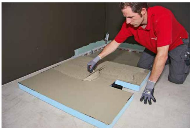
**3** Auf der Rückseite des Duschelements wird Fliesenkleber (Sopro's No.1 S1 Flexkleber) für die Verklebung zum Untergrund aufgetragen. Der Untergrund wird ebenfalls mit Fliesenkleber abspachtelt.
