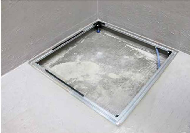
**1** Entwässerungsrahmenträger eingepasst in die Duschecke. Mittels Systemdichtbändern angeschlossen an die Verbundabdichtung, hergestellt mit Sopro FlächenDicht flexibel oder Sopro DichtSchlämme Flex 1-K.
