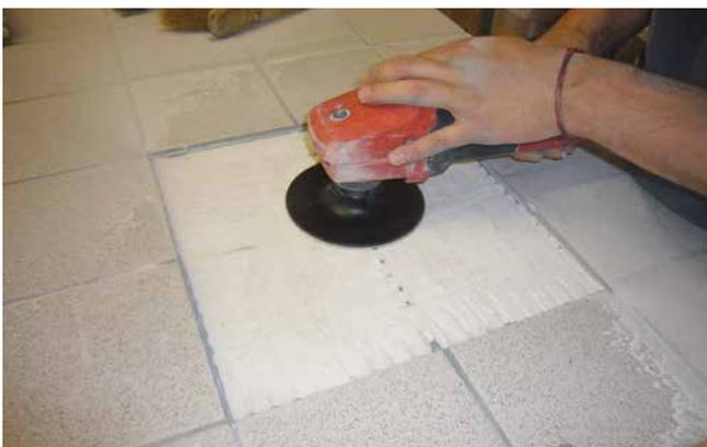
**5** Damit das Verlegen der neuen Fliese nicht mit einem Höhenversatz bzw. Überzahn ausgeführt wird, ist der alte Kleber mit einer Sandpaperscheibe von der Abdichtung herunter zu schleifen. Ist dies geschehen, kann mit der Neuverlegung der Fliesen begonnen werden.
