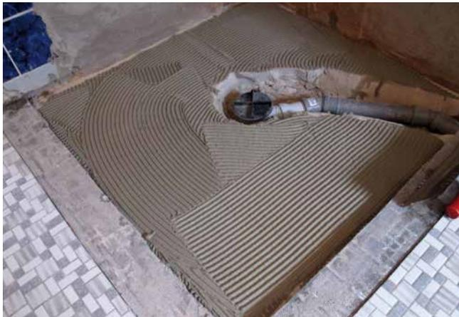
3 Das Duschelement wird mittels Fliesenkleber (Sopro's No.1 S1 Flexkleber) auf der planebenen Fläche verklebt.
