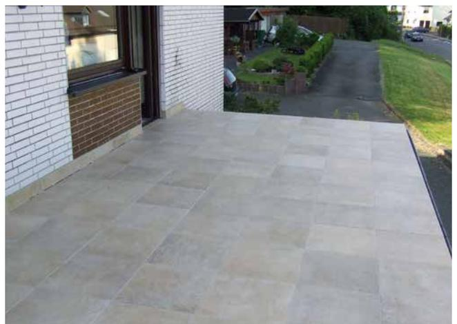
6 Fliesen verlegt mit hochflexiblem Dünnbettmörtel Sopro megaFlex S2 und verfugt mit Sopro DF 20® DesigFuge Flex Breit.
