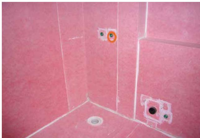
**4** Alle Stöße sowie die Manschetten im Bereich von Durchdringungen (Rohre, Bodenabläufe etc.) sind mit Sopro Racofix® Montagekleber (S) wasserdicht zu verkleben.
