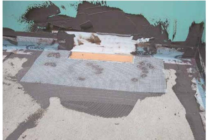
4 Abdichten des Bodenablaufelements und der Fläche mittels Dichtbändern und Gewebeeinlagen sowie Sopro TurboDichtSchlämme 2-K.
