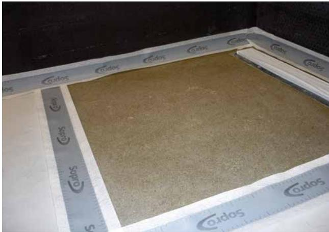
1 Vorbereiten der notwendigen Sopro Dichtbänder, welche in die Sopro DichtSchlämme Flex 1-K eingearbeitet werden sollen.
