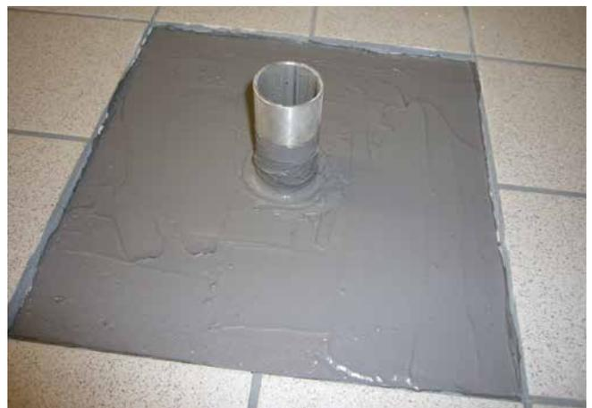
**4** Fertig eingedichtete Durchdringung. Nach der Aushärtung können die fehlenden Fliesen neu ergänzt werden. Es ist darauf zu achten, dass die Verfugung zwischen Rohr und Fliese elastisch zu verfüllen ist.
