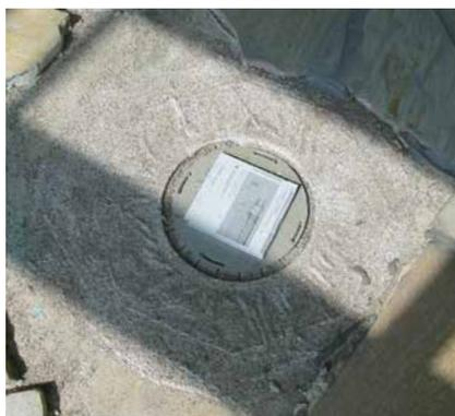
System ACO: eingebaut und in die Flächenverbundabdichtung integriert.
