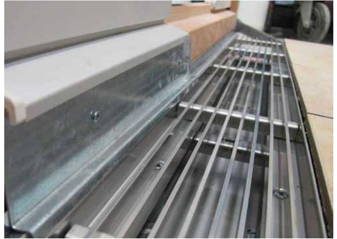
**8** Zum Schutz der Abdichtung und einer sauberen Ableitung des Wassers von der Tropfkante des Türelements in die Rinne (ACO) ist ein Blech vom Spengler einzusetzen und zu fixieren.
