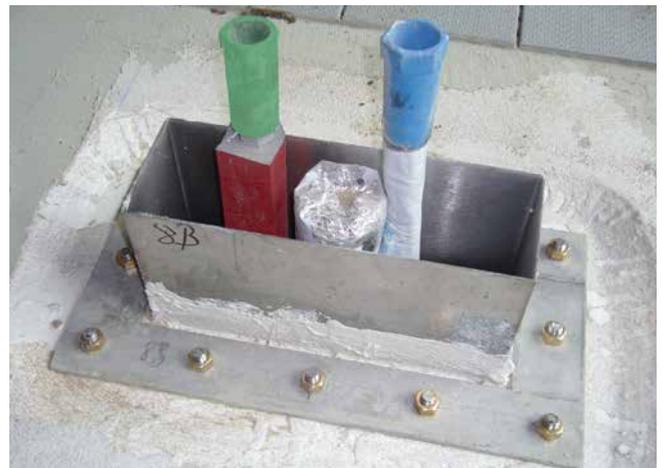
Hüllrohr mit Pressdichtflansch eingedichtet mit Verbundabdichtung.
