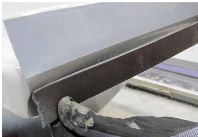
2 Ankleben eines Schaumstoffstreifens zur Vermeidung von Schallbrücken bei der Montage der Badewanne.
