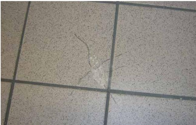
**1** Durch äußere Einflüsse kann es zu Schäden an den Fliesenbelägen z. B. in Form von Rissen oder Glasurabplatzungen kommen. Damit die Abdichtung bei der Reparatur der Fliesen nicht beschädigt wird, sind folgende Schritte sorgsam durchzuführen.
