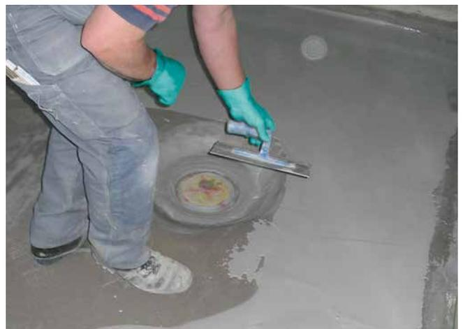
Applikation der flexiblen, mineralischen Dichtungsschlämme.
