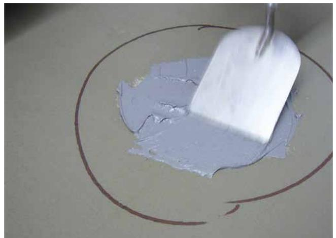
Verfüllen der Messstelle mit dem Verbundabdichtungsmaterial.
