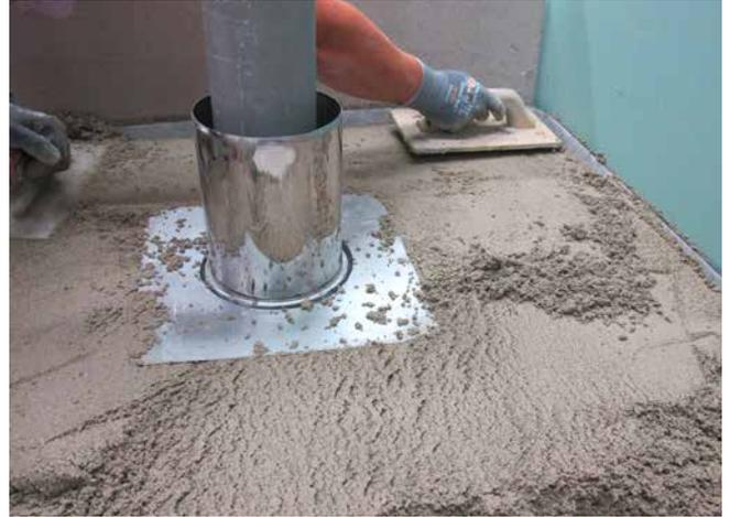
**2** Einbau des lastverteilenden Zementestrichs mit dem zweiten Hüllrohr, welches im Estrich fixiert ist und Hüllrohr 1 umschließt.
