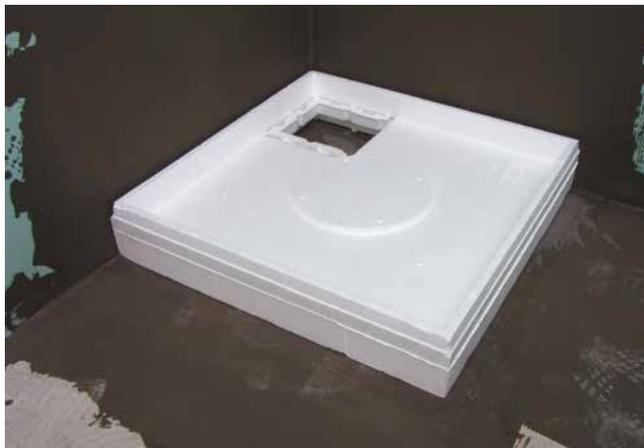
Der Wannenträger (System Kaldewei) wird in der Duschecke aufgestellt.
