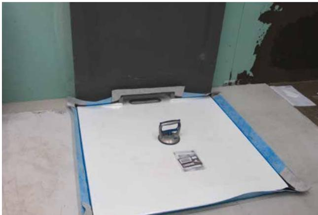
3 Die Duschfläche ist im Estrich oberkantenbündig zum angrenzenden Fliesenbelag versetzt. Die Entwässerung ist in die Wand verlagert. Ein Schedel-Wandelement kann hier hilfreich sein.
