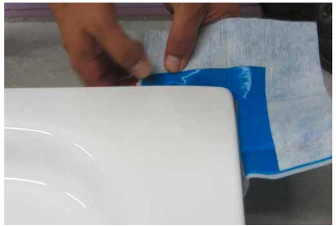
2 Eine sichere Anbindung zwischen Wannenanrand und Abdichtungsmasse (Sopro DichtSchlämme Flex) ist gegeben.
