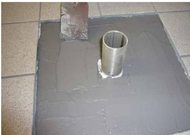
**3** Sorgfältiges Eindichten der Durchdringung ist entscheidend für die Langlebigkeit der Maßnahme.
