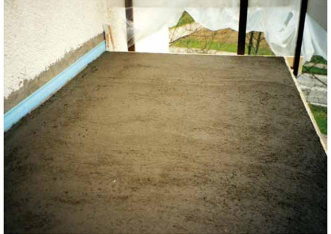
2 Mit Gefälle vorbereitete Fläche zur Aufnahme der Verbundabdichtung (Sopro DichtSchlämme Flex).
