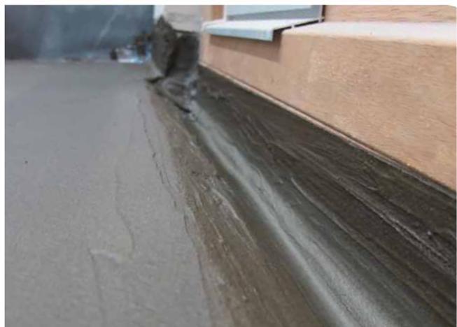
4 Abgedichtete Balkonfläche mit Anschluss an das Türelement.
