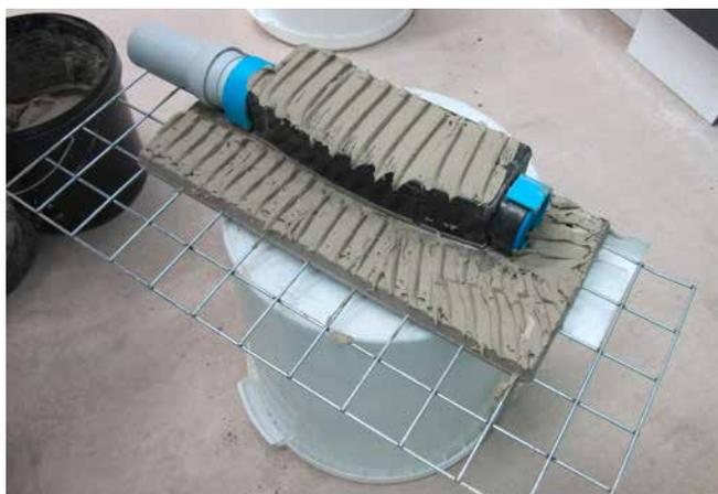
1 Abspachteln des Dallmer Bodenablaufelements mit Sopro's No.1 S1 Flexkleber für einen guten Haftverbund zum Estrichmörtel.
