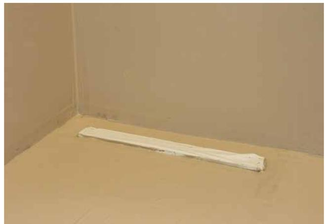
6 Abgedichtete Duschecke nach zwei Arbeitsgängen mit einer Mindestabdichtungsschichtdicke von 2 mm. Nach der Aushärtung kann unmittelbar mit einem zugelassenen Dünnbettmörtel (Sopro's No. 1 S1 Flexkleber) mit der Fliesenverlegung begonnen werden.
