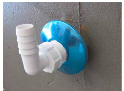
Unterschiedliche Durchmesser der Durchdringungen lassen sich mit dem Sopro AEB® Wandmanschetten-Sortiment auf der Baustelle sicher in der Kombination mit den Sopro Verbundabdichtungsmaterialien ab- und eindichten.
