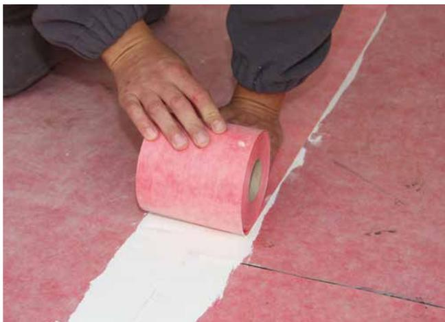
9 Überkleben des Stoßbereichs mit dem Sopro AEB® Dichtband. Optional kann die wasserdichte Verklebung des Dichtbandes auch mit Sopro Racofix® Montagekleber S oder Sopro TurboDicht-Schlämme 2-K erfolgen.
