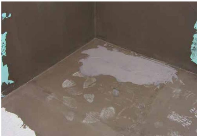
Aufgrund des Deckenaufbaus ist eine Versenkung der Duschtasse in den Boden nicht möglich. Die Boden- und Wandflächen sind mit einer Verbundabdichtung (Sopro DichtSchlämme Flex 2-K) abgedichtet.
