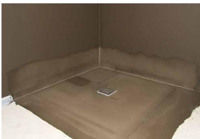
**6** Abgedichtete Fläche, bereit für die folgende Fliesenverlegung.
