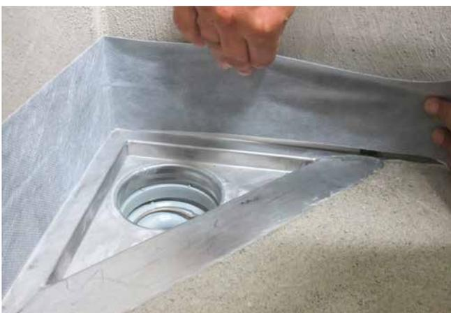
5 Sorgfältiges Eindichten des Entwässerungselements mittels selbstklebender Dichtbänder (Sopro FlexDichtBand).
