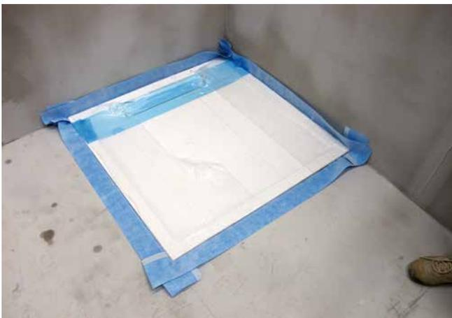
**1** Duschtassenelement mit angeklebten Dichtbändern (Systemkomponente), welche ein Anarbeiten an die Verbundabdichtung ermöglicht.
