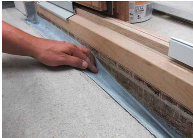
2 Einkleben des Sopro FlexDichtBand in die abzudichtende Fuge.
