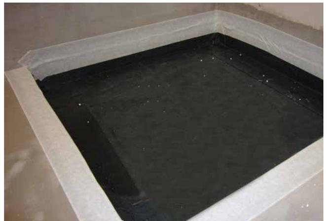
6 Mit SoproThene® Bitumen-Abdichtungsbahn abgedichtete Duschecke, überklebt mit SoproThene® Abschlussband Vlies zum Anschluss für die folgende Verbundabdichtung.
