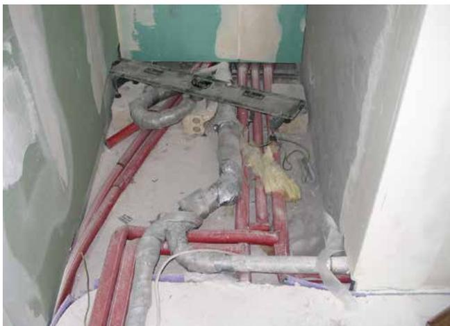
Die Führung von Versorgungsleitungen in den ausgesparten Bereichen erschweren den Abdichtungsprozess.
