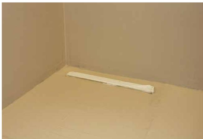
6 Komplett abgedichtete Duschecke in zwei Arbeitsgängen (Wand- und Bodenfläche) mit Sopro DichtSchlämme Flex 1-K, bereit für die folgende Fliesenverlegung.
