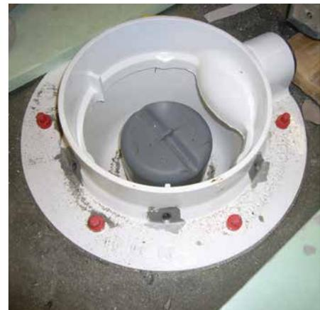
Entwässerungstopf zur Zwischenentwässerung einer Abdichtungsebene.
