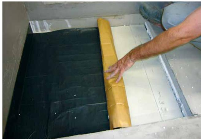
**2** SoproThere® Bitumen-Abdichtungsbahn unterhalb der Duschtasse.
