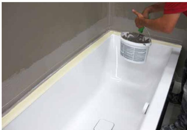
4 Eindichten des Wannendichtbandes (System MEPA – Pauli und Menden GmbH) mit Sopro FlächenDicht flexibel im Wandbereich.
