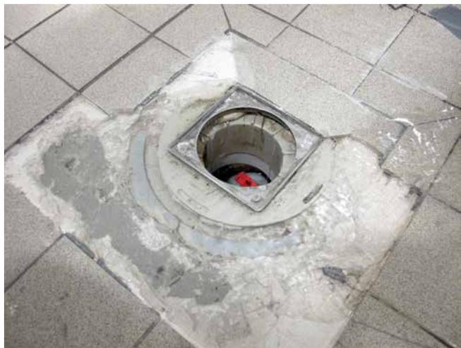
Werkseitig montierter Dichtflansch wurde – weil im Weg – abgeschnitten. Keine Anschlussmöglichkeit zur Dichtungsschlämme mehr möglich.
