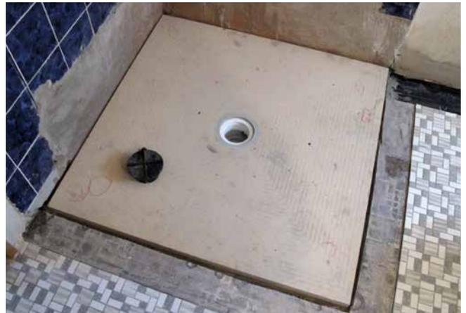
4 Eingesetztes Duschelement (MEPA – Pauli und Menden GmbH) bereit für die Abdichtungsarbeiten.
