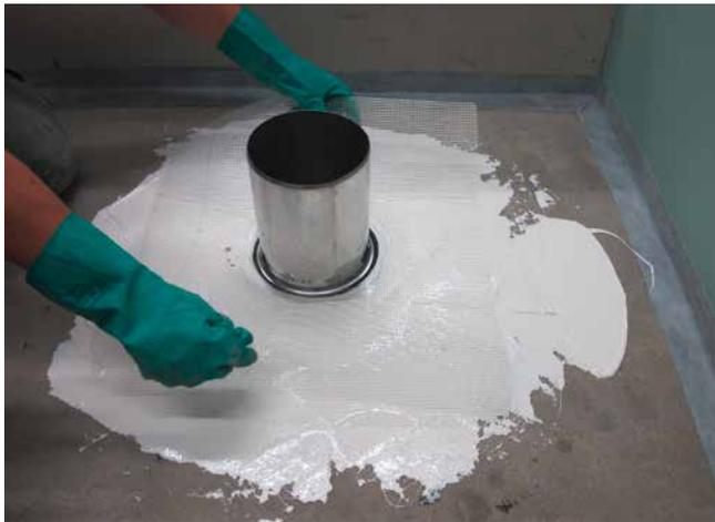
**3** Das Hüllrohr wird nach den Grundierarbeiten mit Sopro Epoxigrundierung und der Quarzsandabstreuung mit Sopro PU-FlächenDicht abgedichtet. Im Bereich der Durchdringung wird die Abdichtung durch eine Gewebeeinlage verstärkt.
