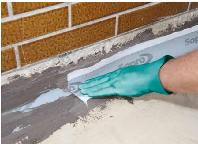
3 Einarbeitung und Fixierung der Dichtbänder und Formteile mit Sopro DichtSchlämme Flex zu Beginn der Abdichtarbeiten.
