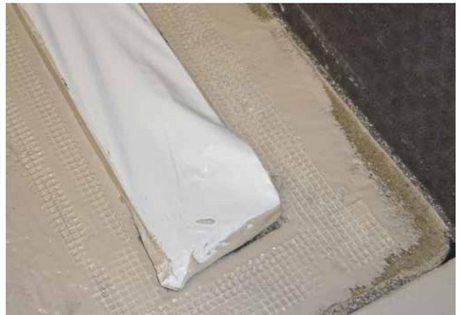
4 Einbetten von Sopro Armierung in die Sopro DichtSchlämme Flex 1-K im Bereich von Flanschen als Übergangverstärkung.
