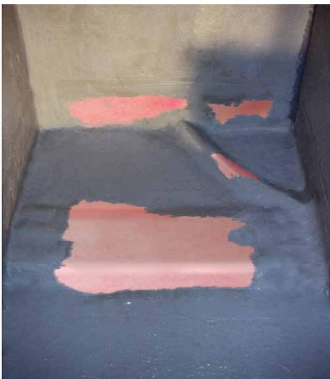
Ergänzung der Verbundabdichtung durch Einarbeiten von Sopro AEB® Abdichtungs- und Entkopplungsbahn-Teilstücken im Bereich der Rohre und Installationen. Dabei werden die Enden der Teilstücke vollsatt in die flüssig zu verarbeitende Verbundabdichtungsmaße eingearbeitet und überarbeitet.
