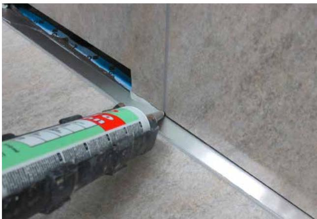
**11** Die Wassersammelschiene hat einen Abstand zur Wand von ca. 5 mm (wegen des schwimmenden Estrichs). Die Fuge zur Wandfliese ist mit Silicon (Sopro SanitärSilicon) elastisch zu schließen.
