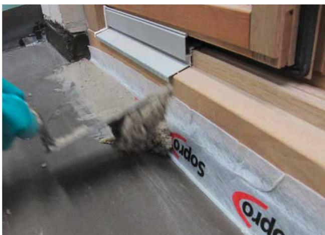
5 Nach dem Einstellen eines Randdämmstreifens wird die Vertiefung mit einem schwindarmen und kapillardichten Reaktionsharzmörtel verfüllt.
