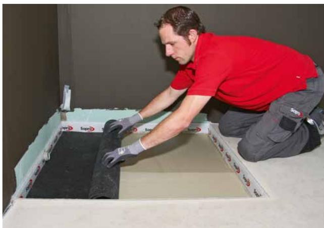
**2** Verkleben einer Schallschutzbahn auf der planebenen Fläche mit Sopro's No.1 S1 Flexkleber.
