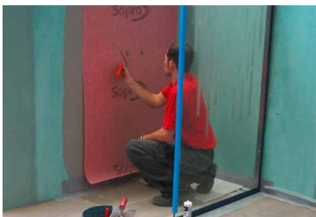
5 Die Abdichtung der Wandfläche erfolgt mit Sopro AEB® Abdichtungs- und Entkopplungsbahn. Diese wird mit Sopro's No.1 S1 Flexkleber verklebt.
