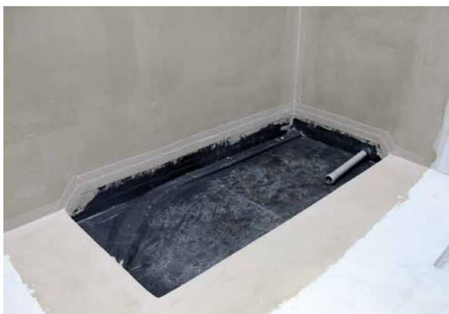
6 Komplett abgedichtete Badewanenecke, bereit für den Einbau und Anschluss der Badewanne.
