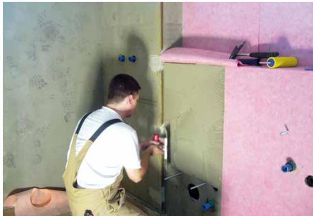
**2** Aufspachteln des Fliesenklebers (Sopro's No. 1 S1 Flexkleber) mit einer feinen Zahnpachtel. Die Flächen sind im Vorfeld mit Sopro Grundierung zu grundieren.
