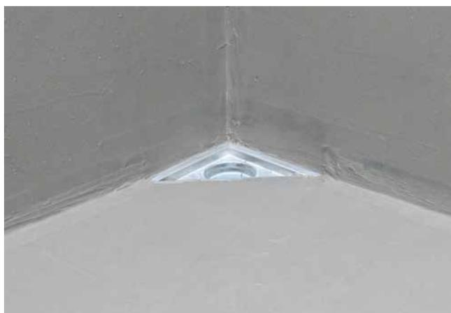
6 Abgedichtete Duschecke mit Sopro DichtSchlämme Flex 1-K.
