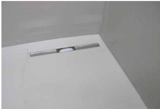
4 Fertig eingedichtete Rinne und abgedichtete Duschfläche mit der Flächenverbundabdichtung (Sopro DichtSchlämme Flex 1-K).
