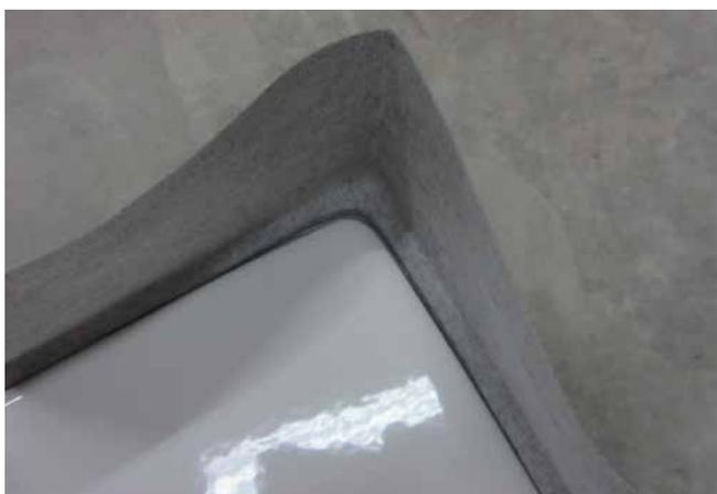
1 Der Dichteckenradius passt sich an die Wanne an, während das obere Ende zu einer scharfkantigen 90°-Ecke zur Wand hin geformt ist.
