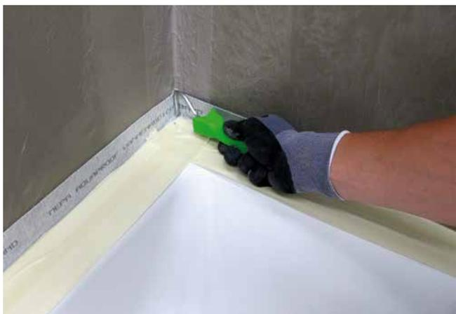
3 Das Wannendichtband lässt sich aufgrund einer senkrechten Perforierung auch in Ecken sehr gut verkleben.
