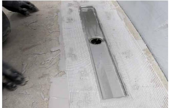
2 Einlage einer Armierungsgewebemanschette zur Verstärkung der Verbundabdichtung (Sopro DichtSchlämme Flex 1-K) im Übergangsbereich von Flansch zu Estrich.
