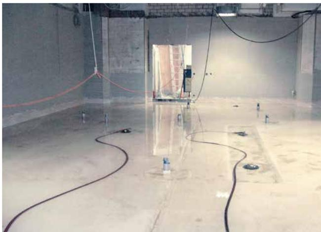
Prüfung der Bodenabdichtung auf Dichtigkeit durch Flutung.
