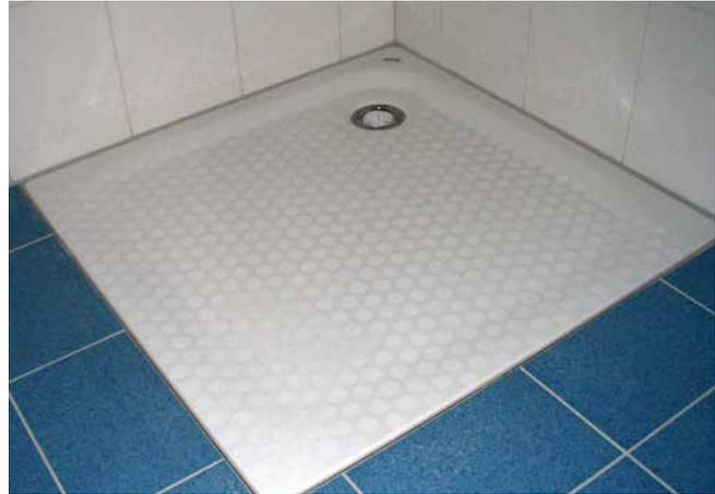
**2** Duschtassenelement verlegt auf dem Entwässerungsrahmenträger, eingefliest und verfugt. Die Fuge zwischen Keramik und Duschtasse ist mit Sopro SanitärSilicon zu schließen.
