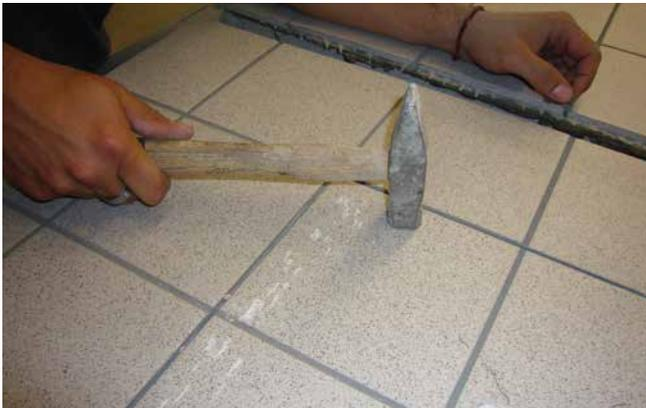
**3** Ist die Fuge eingeschnitten, wird mit einem Hammer die Fliese mit leichten Schlägen zertrümmert. Die Einzelstücke der Fliese werden entfernt.
