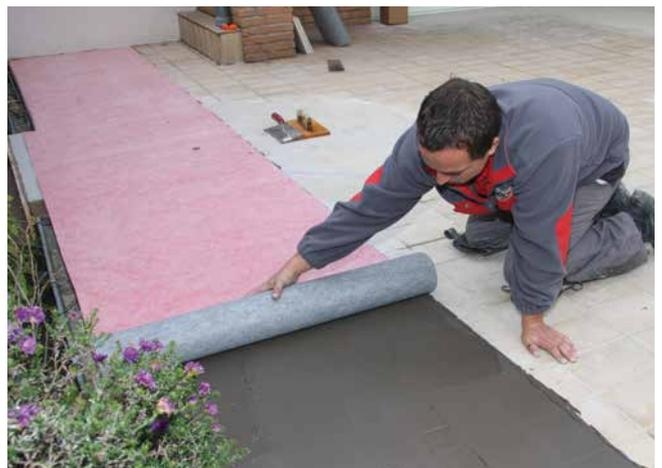
4 Verlegen der AEB® plus Abdichtungs- und EntkopplungsBahn plus in das vorbereitete Mörtelbett.
