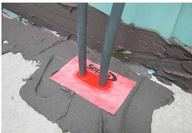
Leitungsführungen von Heizkörpern lassen sich ebenfalls sicher mittels der Sopro AEB® Wandmanschette 131 eindichten.
