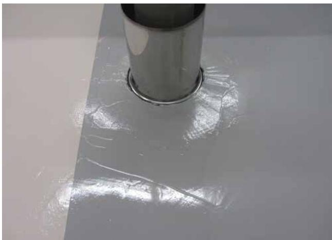
**5** Mittels Kontrastfarbe lässt sich die zweite Schicht Sopro PU-FlächenDicht einfärben. Das Arbeiten wird durch diese Sichtkontrolle erleichtert.
