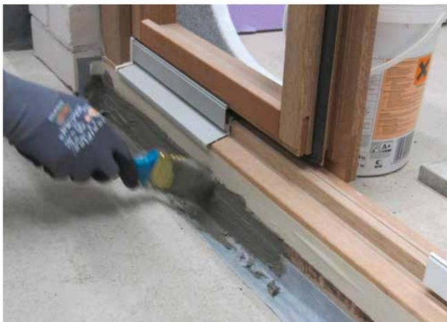
3 Abdichten der Fuge mit Sopro TurboDichtSchlämme 2-K.
