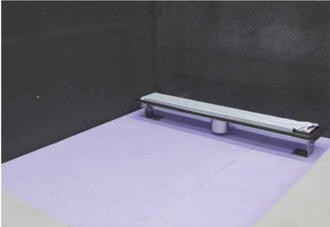
1 ACO-Entwässerungsrinne in einer Duschfläche auf Dämmung.
