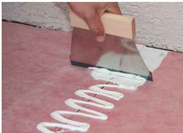
8 Verteilen des Sopro Racofix® Montageklebers mit einer Zahnleiste im Stoßbereich.
