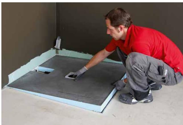
**4** Einsetzen des Duschelements in die Duschecke bzw. Aussparung des Estrichs.
