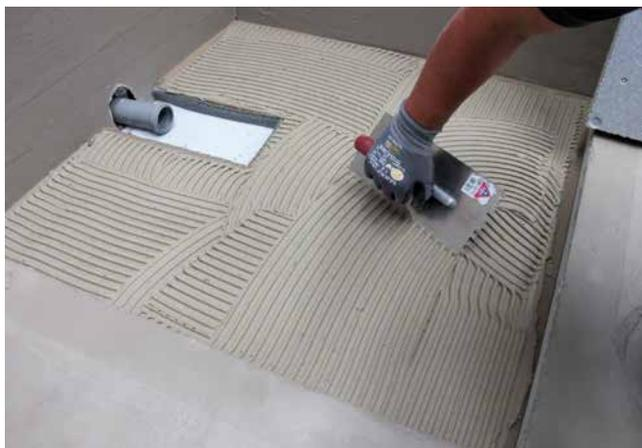
2 Aufziehen des Kleberbetts (Sopro's No. 1 S1 Flexkleber) auf der planebenen Verlegefläche.
