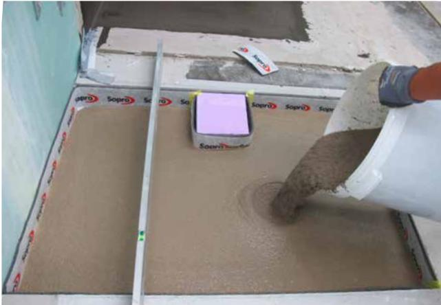
1 Herstellen einer planebenen Fläche mit Sopro Rapidur® FE Fließ-Estrich für die Aufnahme des Duschelements.
