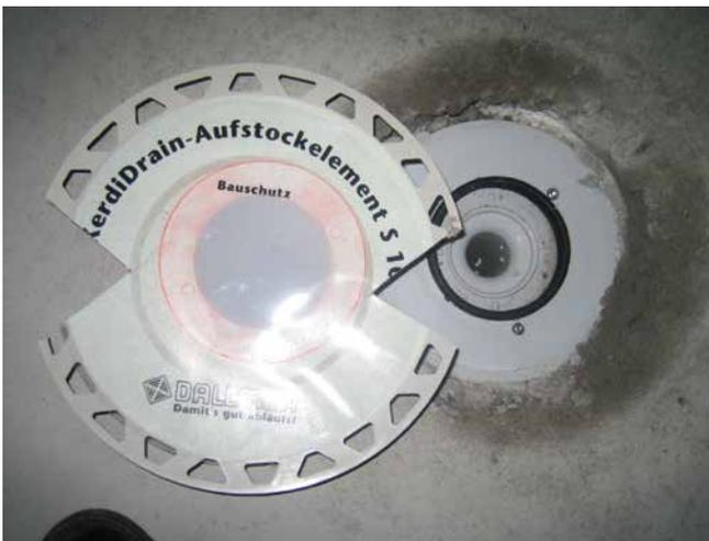
Aufstockelement mit breitem Klebeflansch für die Verbundabdichtung wurde zur einfacheren Montage (Verguss) aus Gedankenlosigkeit zerstört.
