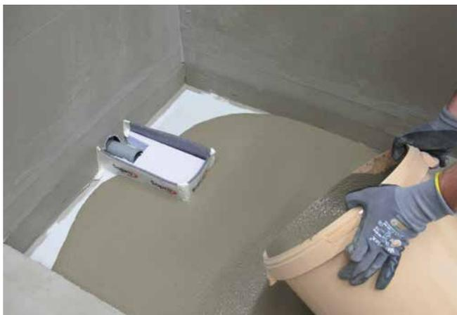
1 Herstellen einer planebenen Verlegefläche mit Sopro Rapidur® FE Fließestrich zur sicheren Aufnahme des Duschelements.
