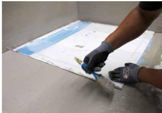
**2** Eindichten der Duschtasse mit Sopro FlächenDicht flexibel oder Sopro DichtSchlämme Flex 1-K mit einfachen Handgriffen.
