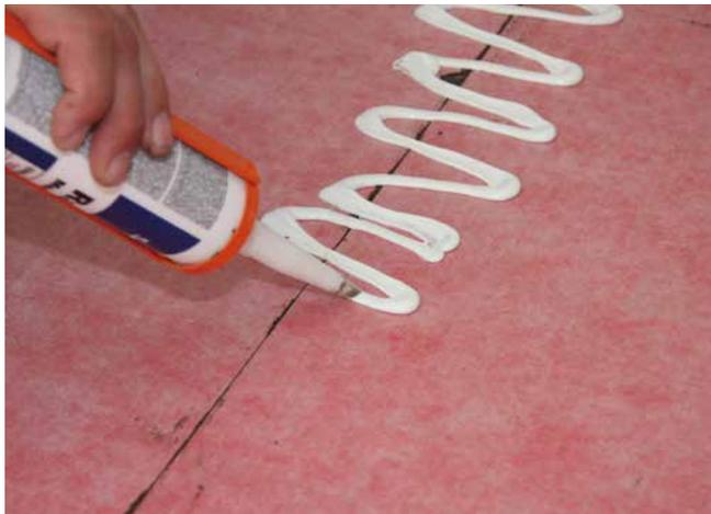
7 Auftragen des Sopro Racofix® Montageklebers zum Abdichten des Stoßbereichs.
