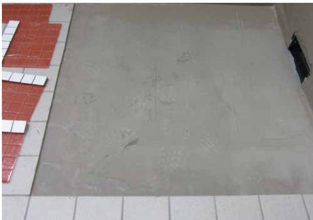
4 Die Fläche ist mit einer Verbundabdichtung (Sopro DichtSchlämme Flex 2-K) abgedichtet. Nach der Trocknung erfolgt die Verlegung des Mosaiks.
