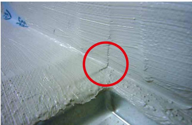
Dichtband liegt nach den Abdichtarbeiten press an – eine Kanalbildung und Hinterläufigkeit ist nicht gegeben.
