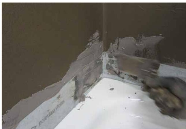
2 Die Dichtecke lässt sich z. B. mittels Sopro DichtSchlämme Flex leicht in der Raumecke einarbeiten.
