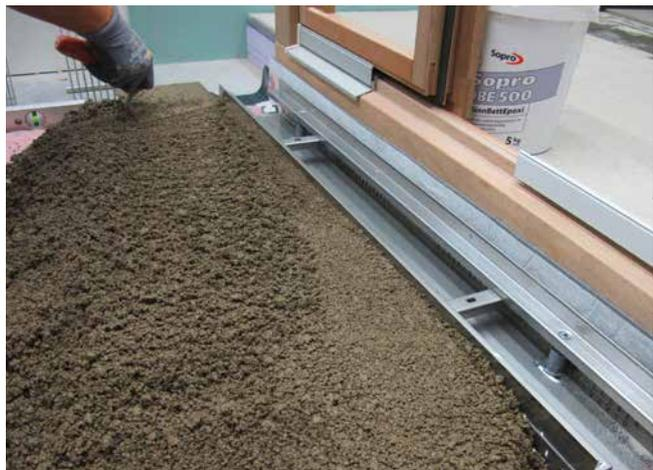
4 Der Sopro DrainageMörtel eXtra wird in einer Mindestdicke von 50 mm auf der Sopro DrainageMatte aufgebracht. Anschließend vorverdichtet und abgezogen.
