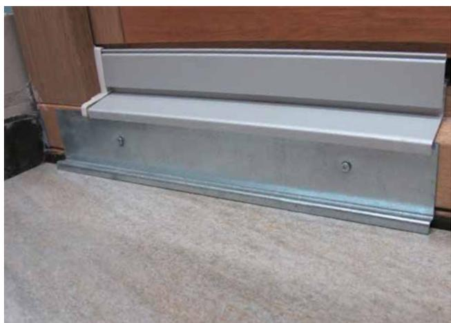
6 Die Fliesenverlegung erfolgt im Dünnbettverfahren mit Sopro megaFlex S2 MEG 665. Zum Türelement hin erfolgt der Abschluss mit einer Schiene.
