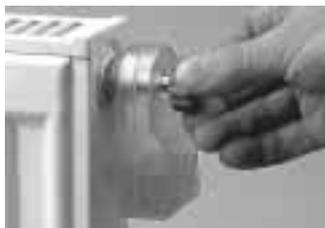
einen transparenten, alterungs- und hitzebeständigen Behälter aus Polystyrol abfließt. Durch seine geringe Bautiefe sind selbst enge Heizkörpernischen gut erreichbar. Sehr gut geeig-
