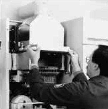
**Die Bauteile – hier der Wärmetauscher – lassen sich problemlos von vorn erreichen . . .**
