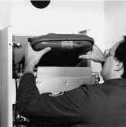
**. . . Nach seiner Demontage kann auch das Ausdehnungsgefäß rasch entfernt werden**
