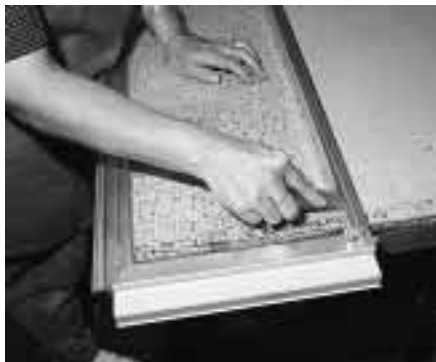
In der Montagehalle erfolgt der Zusammenbau der Rahmen und das Einlegen von Scheibe und Dichtung
