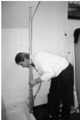
Die gewünschte Gesamthöhe der Duschabtrennung läßt sich am besten mit Teleskopmaßstab feststellen
