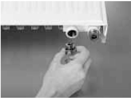
**. . . oder mit Hilfe eines Doppelnippels an Gewindemuffen mit Innengewinde Rp  $\frac{1}{2}$**
