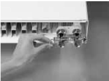
**Mit einem Innensechskantschlüssel kann das Ventil von der werkseitigen Einrohr-einstellung auf Zweirohrbetrieb umgestellt werden**
