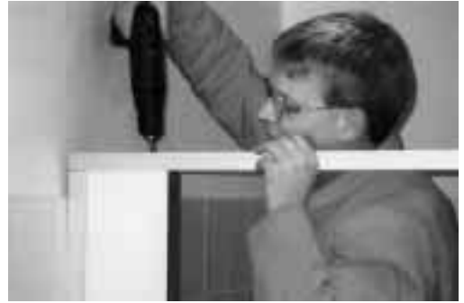
. . . Aus dem gleichen Profil erhalten die Frontwände oberhalb der Tür eine Versteifung
