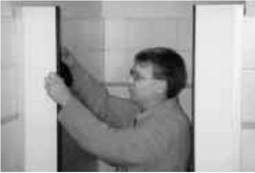
Die nach Maß vorgefertigten Platten werden mit Hilfe von Profilschienen an der Wand befestigt . . .
