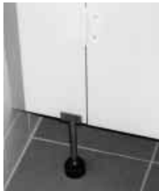
Die Trennwände werden über höhenverstellbare Edelstahlfüße am Fußboden befestigt
