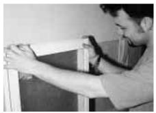
Aus der Montageanleitung ist die gelieferte Art der Duschabtrennung ausfindig zu machen. Die Anleitung zeigt, welche Teile an welche Stelle gehören, wie sie zusammenzusetzen sind und wie die Duschabtrennung anzubringen ist
