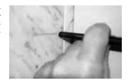
Ist die Montageschiene nicht bereits werkseitig mit Löchern zur Befestigung des Rahmens der Duschabtrennung versehen, sollte – besonders bei farbbeschichteten Profilen – vorgebohrt werden. Dadurch läßt sich das "Wandern" der Schraube bei einer Befestigung mit dem Bohrschrauber vermeiden
