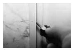
Schließlich kann die Duschabtrennung in die Montageschiene eingesetzt werden. Das Ausrichten geschieht entsprechend der Oberkante der Badewanne, damit die Abtrennung beim Duschen auch dichtend auf dem Wannenrand aufsitzt. Nun erfolgt die Befestigung in der Montageschiene
