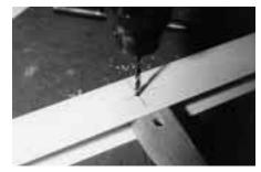
Nach dem Setzen des Dübels wird die Montageschiene lose befestigt, mit Hilfe der Wasserwaage ins Lot gebracht und dann endgültig festgeschraubt
