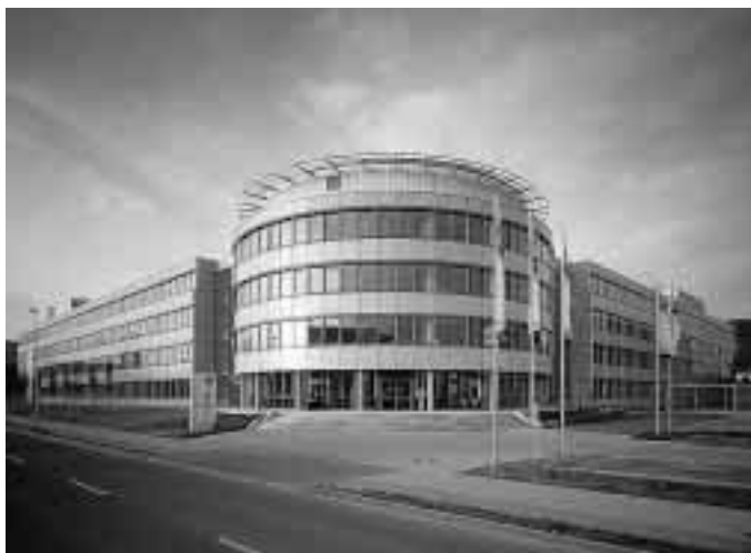
Im Rondell des neuen Technologiezentrums der Jenoptik befindet sich das über vier Stockwerke reichende Foyer [1]
