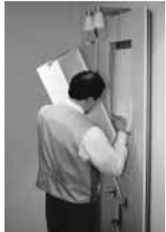
**Nun werden die Leuchten befestigt, die Stromanschlüsse hergestellt und der Spiegelschrank eingesetzt und festgeschraubt**
