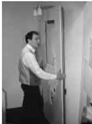
**Die Frontplatte wird nun vor die Traverse gestellt, waage- und lotrecht ausgerichtet sowie an der Traverse ...**
