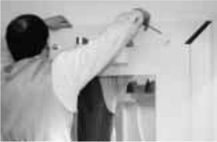
**Die Rahmenleisten sind mittels Montageklötzen an der Funktionsschiene der Frontplatte anzubringen**
