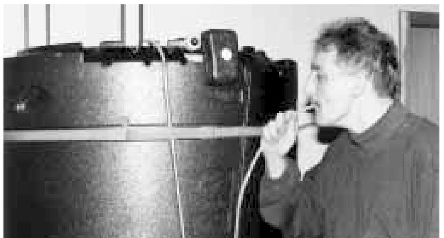
**Jetzt kann der Speicher mit Wasser gefüllt werden, wobei über den Füllstandsschlauch Wasser anzusaugen ist, um die Füllhöhe des Inhaltes sichtbar zu machen**
