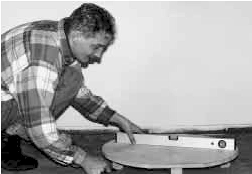
Bei der Montage des Speichers wird als erstes die Bodenplatte eben aufgestellt
