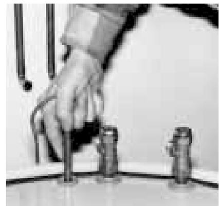
. . . während der Temperaturregler des Kesselreglers in die Tauchhülse geschoben wird
