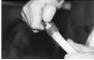
**Der Quick & Easy-Ring preßt das Rohrende durch Schrumpfen dauerhaft auf das Formstück (Bild: Wirsbo)**
