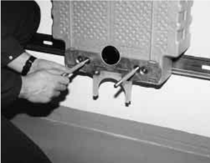
Die obere Befestigung geschieht mit einer speziellen Lasche
