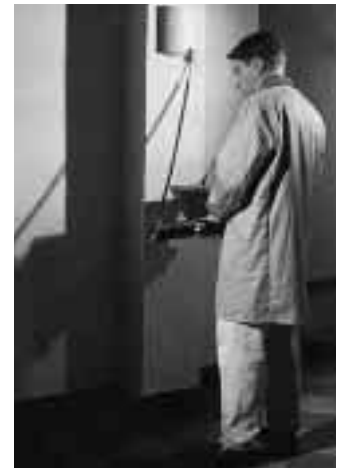
Der Ableser übernimmt die Meßdaten vom Empfangsteil, das frei zugänglich außerhalb der Wohnungen angebracht ist
