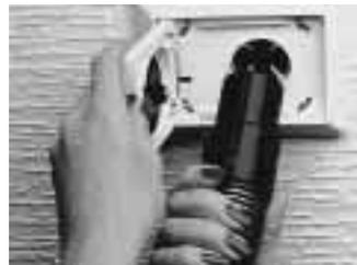
**Der Staubsauger wird beim Öffnen der Saugdosenklappe über die Steuerleitung in Betrieb gesetzt**
