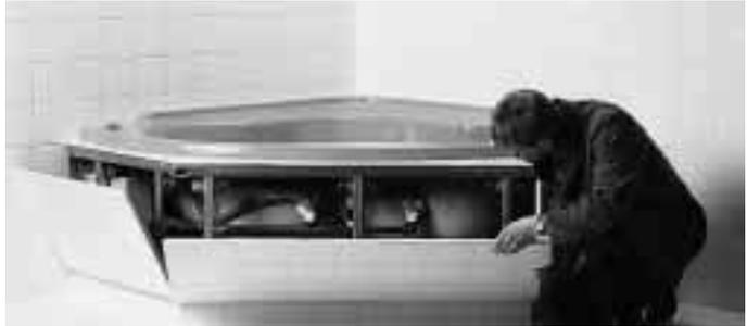
**Als Verkleidung empfiehlt der Hersteller das im Werk entwickelte System Jetline, das aus Unterkonstruktion und Verkleidungsklappen besteht**
