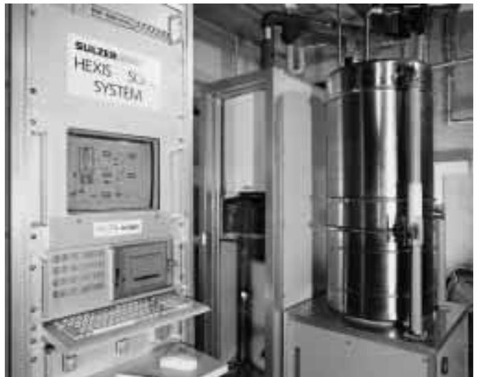
**Die Anlage in Winterthur besteht aus dem Brennstoffzellenmodul (r.), Gastherme und WW-Speicher (M.) und dem Steuerungsschrank**
