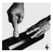
• Haltestift abschneiden. Allerdings: Der Installateur muß sicher sein, daß das zu reparierende Rohr aus reinem unvernetzten Polyethylen be-
