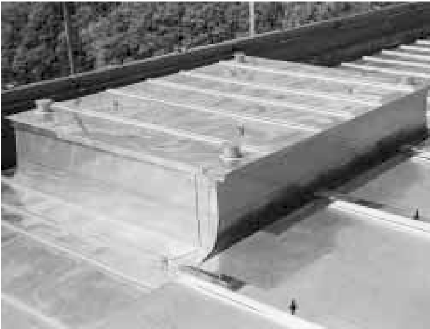
Sechs Dachdurchdringungen waren ebenfalls vollständig mit Chrom-Nickel-Stahl zu bekleiden [7]
