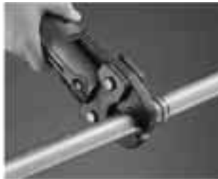
Preßbacken rechtwinklig auf Preßfitting setzen und verpressen
