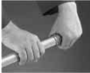
Fitting und Rohr leicht drehend ineinander-schieben
