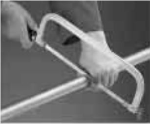
Rohr rechtwinklig ablängen
