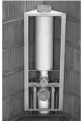
Der Spülbehälter vom Typ MSR kann in der Badezimmerecke oder in einem Schachtelement der Vorwandinstallation angeordnet werden
