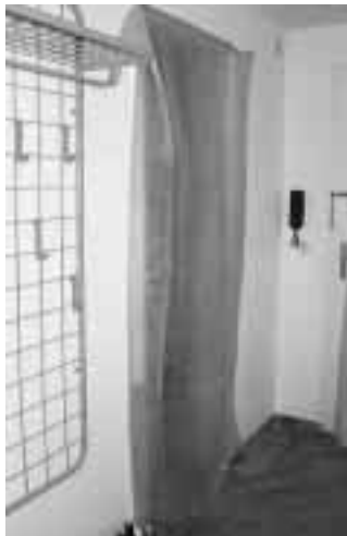
Zur Renovierung von Küche und Bad sind die Türrahmen mit Plastikfolie gegen die Wohnung hin abgedichtet
