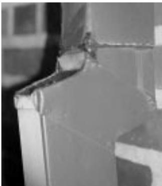
nerotechnik. Von der scheint der Hersteller dieses Fallrohr-Etagenstückes allerdings nichts zu verstehen. Nicht nur, daß er beim Zusammenfügen der einzelnen Teile des Etagenstückes aufs Falzen verzichtete und zu Silikon und Blindnieten griff. Auch von der Fließrichtung des Wassers scheint er noch nichts gehört zu haben, denn das von oben kommende Fallrohr wurde über das Etagenstück geschoben. Gesehen wurde diese „Facharbeit“ am relativ neuen Mu-
