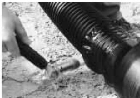
**Der Übergang vom Mantelrohr auf Mauerdurchführung wird mit einem Schrumpfschlauch abgedichtet**
