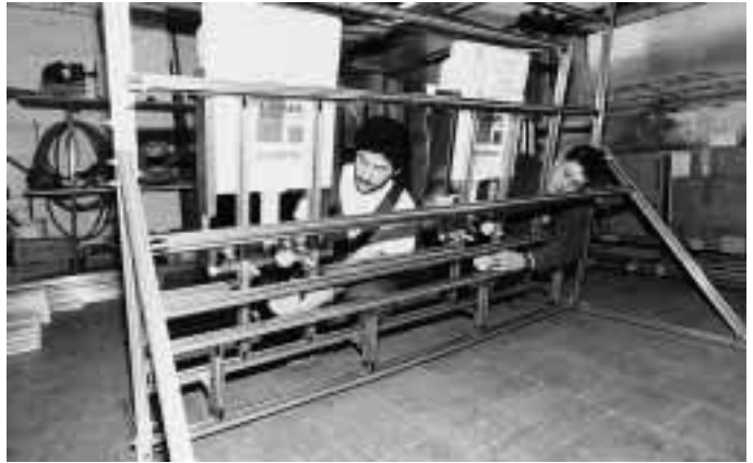
Durch Verwendung von Montagehilfen konnten die Elemente schnell und genau zusammgebaut werden
