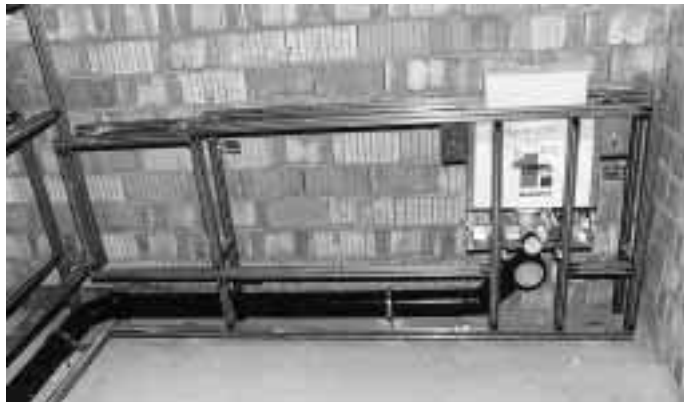
Nach dem Anbringen der GIS-Rahmen am Baukörper erfolgte die Verlegung der Abwasser- und Trinkwasserrohre
