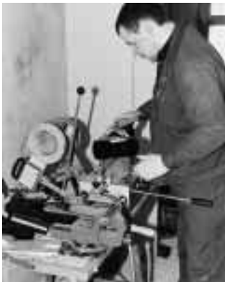
Die einzelnen Teile der Polyethylen(PE)-Abwasserleitung wurden mittels Spiegelschweißen zusammengefügt
