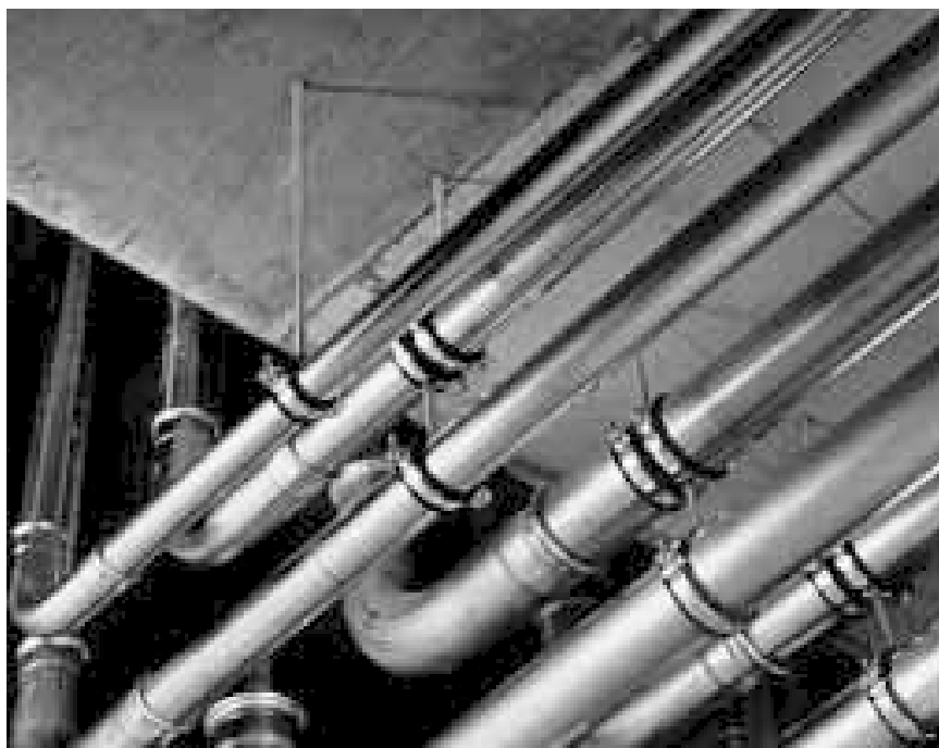
Die Befestigung von Rohrleitungen erfolgt beispielsweise mittels Gewindestangen direkt in einem Anker . . . [1]
