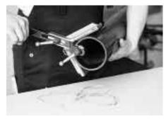
Ausmessen der Muffentiefe, Übertragen des Maßes auf das zu verbindende Rohr und Markieren der Einstecklänge mit dem weichen Bleistift
