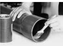
Pinsel mit Kleber tränken und Einsteckende gleichmäßig dünn mit Kleber bestreichen. Die Zeit, die zum Zusammenstecken der Rohre verbleibt, ist von der Umgebungstemperatur abhängig . . .
