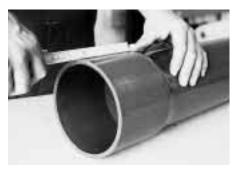
Vliespapiertuch mit Reiniger tränken und das Äußere des Einsteckendes sowie das Innere der Muffe sorgfältig reinigen
