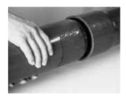
Der beim Zusammenstecken aus der Muffe herausgetretene überschüssige Klebstoff wird mit einem Vliespapiertuch entfernt
