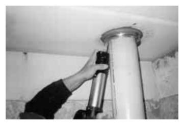
Auch nicht brennbare Rohre müssen brand- und schallschutzgerecht durch Decken und Wände geführt werden
