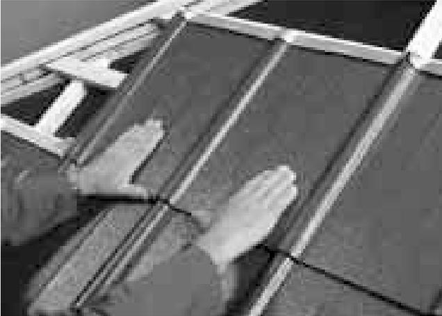
**Die Platte wird über die der unteren Reihe gelegt und soweit nach oben geschoben, bis beide Querfalze ineinander liegen**
