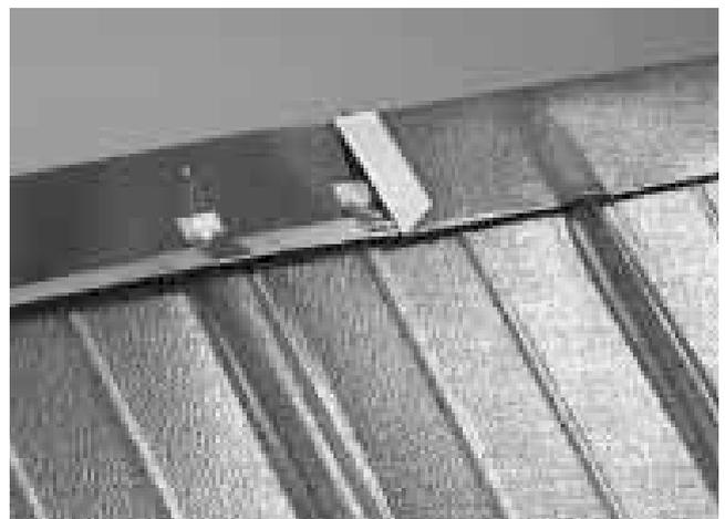
**Der Firstabschluß eines einfachen Pre-fa-Daches kann z. B. mit Hilfe eines Einhängelz hergestellt werden**
