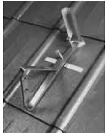
**Um Schneerechenhaken sicher zu befestigen, ist eine Vollschalung erforderlich**
