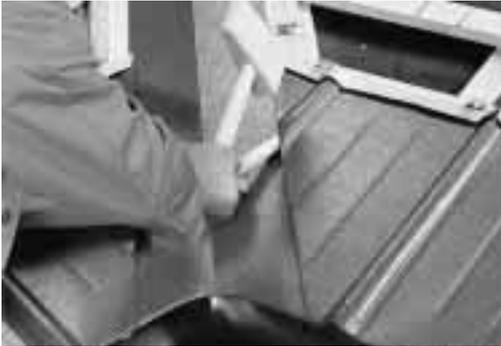
**Die Rille wird mit dem Holzhammer und einem Hammerstil eingeformt**
