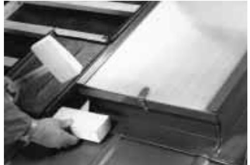
**Mit Hilfe von Holzklotz und Holzhammer wird das Brustblech an die Form der Dachplatten angepaßt**
