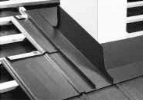
**Die Seitenbleche der konventionell hergestellten Schornsteineinfassung sind mit den anschließenden Dachplatten über Stehfalze verbunden**
