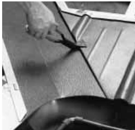
**Die Dachplatten werden entlang der Kehle mit einem 30 mm breiten Zuschlag zugeschnitten, der nach unten um 180 Grad umgebogen in den Wasserfalz der Kehle eingehängt und mit einer Falzzange zuge-drückt wird**
