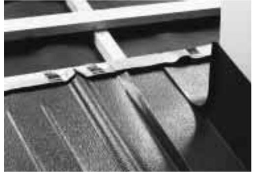
**Am Blech des Schornsteinrückens ist ein Wasserfalz anzuformen, in den die folgende Lage der Dachplatten eingehängt werden kann**
