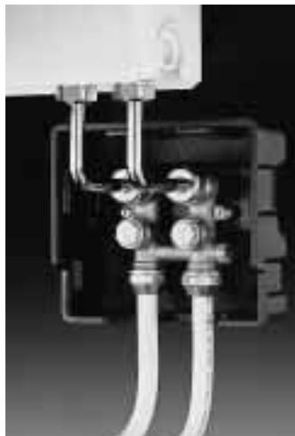
Klemmringverschraubungen. Es wird insbesondere für den Anschluß von Heizkörpern mit integrierter Ventilgarnitur eingesetzt und ist sowohl für den Einrohr- und Zweirohrbe-
