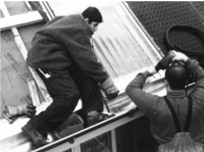
Zwischen den Aluprofilen werden glasfaserverstärkte Well-Kunststoffplatten befestigt [3]
