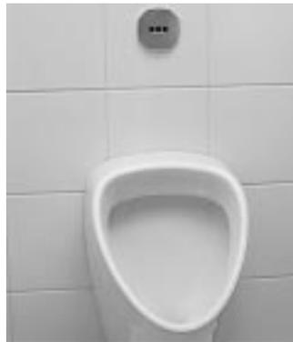
**Die Sensoren der Urinalsteuerung können in der Wand oder – vandalensicher – in der Decke installiert werden**
