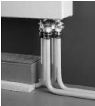
Verbundrohre zur Auswahl. Nach Einbringen des Estrichs und Verlegen des Fußbodens werden Armatur und Heizkörper-Anbindeleitungen mit einer Blende abgedeckt. Die TM-h-Verschraubungen sind absperrbar, so daß der Heizkörper ausgetauscht werden kann, ohne das Heizungswasser der gesamten Anlage ablassen zu müssen.
