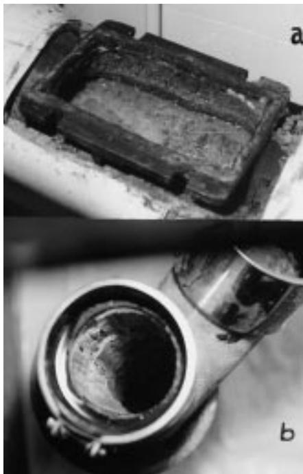
**Nach etwa 4 Wochen Bakterieneinsatz zeigen sich dieselbe Reinigungsöffnung (a) und auch die an der Sammelleitung angeschlossenen Falleitungen (b) nahezu ablagerungsfrei (Bilder: Aladin)**
