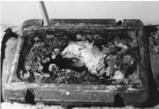
**Selbst starke Ablagerungen in den Abwasserleitungen – wie hier an der Reinigungsöffnung in einer Sammelleitung zu sehen – sind für die Mikroorganismen kein Problem**
