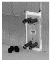
1. Montageschritt: Der Block wird mittels Polyurethanschaum in die Wand eingebaut
