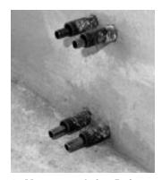
2. Montageschritt: Bei aufgesteckten Schutzkappen (!) erfolgt die Fertigstellung der Wandbekleidung
