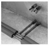
3. Montageschritt: Nach dem Anschluß von Vorund Rücklaufleitung kann die Wärmedämmung vervollständigt werden
