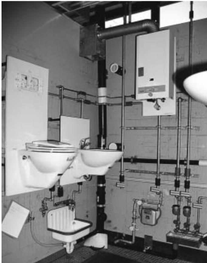
**Montagebox mit einem Ausschnitt aus der praktischen Prüfung (Teil I) der Gas- und Wasserinstallateure . . .**
