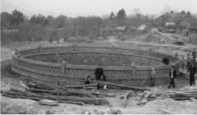
Im Rahmen des umfangreichen Projektes zur Ernährungssicherung wurden über 1000 Trinkwasseranlagen errichtet, darunter Tiefbrunnen, Schachtbrunnen und Zisternen [4]
