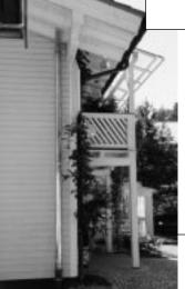
Verbindung von Sonnenkollektor und Warmwasserspeicher hat die Firma Praxenthaler entwickelt. Dabei handelt es sich um ein als Kombirohr gestaltetes Regenfallrohr der Nennweite 120 mm, in das zwei zu 100 % wärmegedämmte Kupferrohre
