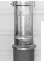
Die Verbindung der Kombirohr-Stücke erfolgt durch Schiebemuffen, die der Kupferleitungen durch Verpressen
