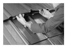
Nun ist der untere Falz der oberen Platte in den oberen Falz der ausgetauschten Platte – anfangs per Hand, später mit der Finne des Handhammers – einzuarbeiten.
