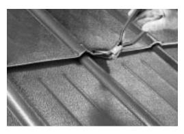
Wird die Platte fachgerecht ausgewechselt, ist der Austausch hinterher nicht mehr feststellbar.
