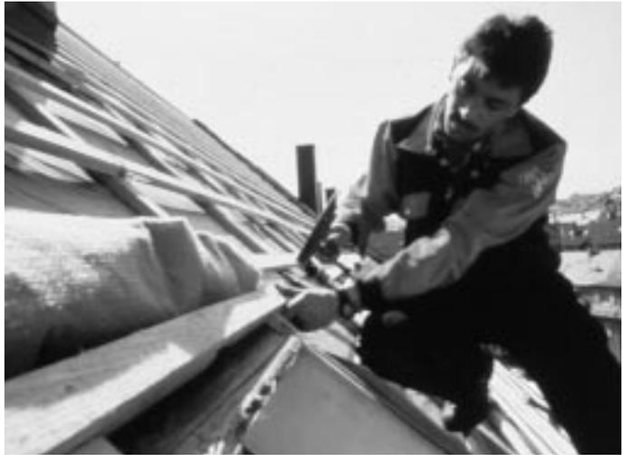
bauen. Die dadurch entstehenden Mehrkosten sind im Vergleich zu den Gesamtkosten eines Daches unerheblich. Dachlatten mit einem Querschnitt von 24/48 mm sollten generell nur noch als Konterlattung verwendet werden. Für diesen Zweck würde dann eine Holzqualität der Sortierklasse II nach DIN 68 365 „Bauholz für Zimmererarbeiten“ ausreichen. Besondere Vorsicht ist bei Dachsanierungen geboten. Hierbei kann man auf sehr alte Dachlatten treffen, deren Tragfähigkeit nur schwer zu beurteilen ist.
