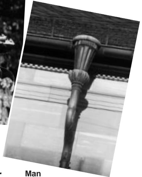
**Niederschlagswasser führt man größtenteils über Regenrinne und Fallrohr in Boden oder Kanal. Den Übergang von der waagerechten Rinne in das senkrechte Rohr bildet oft ein Rinnenstutzen. Über die verschiedenen Arten lesen Sie im Folgenden.**
