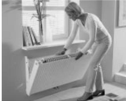
**Durch Abkippen des Heizkörpers, auch während die Heizungsanlage in Betrieb ist, kann die Rückseite leicht gereinigt werden**
