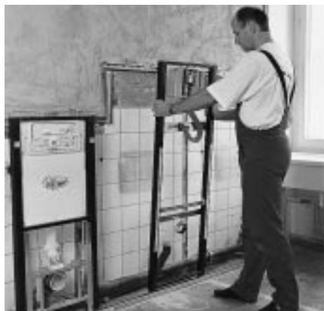
befestigen. Mit Profi-Mont sind außerdem Schachtverkleidung, raumhohe Vorwand, Ecklösungen und Raumteiler realisierbar. Die Elemente werden mit vorgelochter Beplankung aus Fermacell geliefert.
