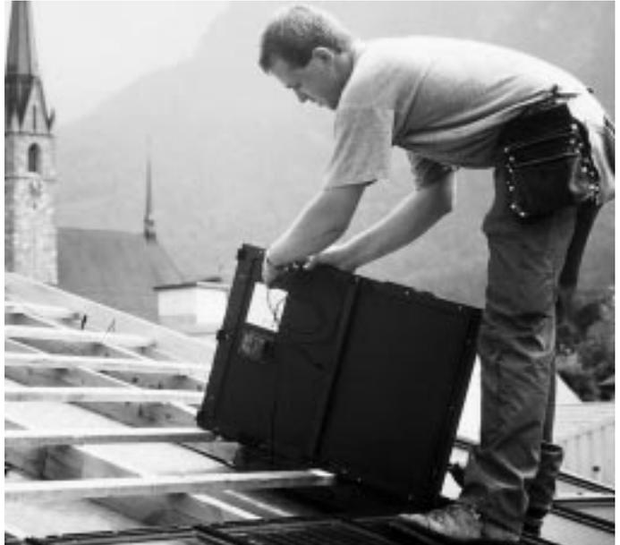
**Die Verlegung von Solar-Dachziegeln ist fast so einfach wie bei einem konventionellen Ziegeldach**
