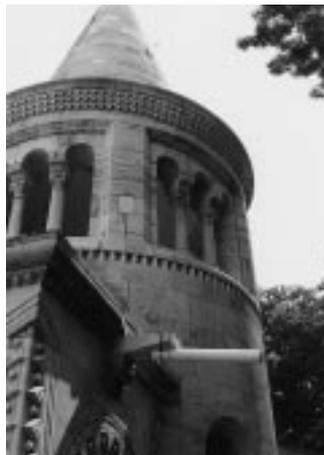
den und möglichst schnell ins Innere des Gebäudes gelangen wollen. Ein Weg in die Räume ist über den Treppenaufgang. Doch genau auf den mündet der Wasserspeier. Eine Korrektur ist unerlässlich. Erst einmal geschah dies provisorisch mit Hilfe eines PVC-Rohres. Nur wissen Sie ja, lieber Leser, dass nichts länger währt als ein Provisorium. Bleibt abzuwarten, bis sich jemand daran macht und eine ordentliche Lösung des Problems herbeiführt.
