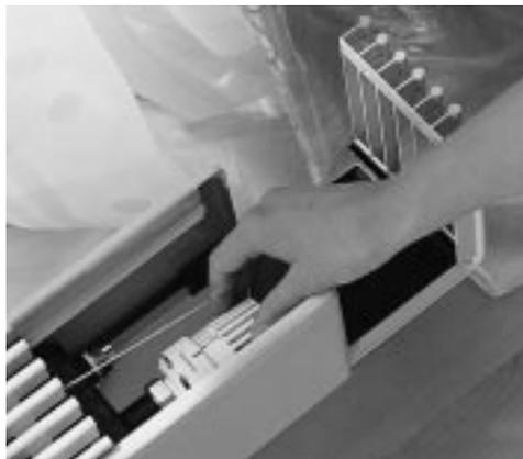
tiert mit Ventil und Thermostat geliefert. Obwohl durch die Verkleidung abgedeckt, sind diese dennoch jederzeit gut zugänglich. Ein feingestuftes Leistungs- und Größenraster sichert einfache Auswahl des passenden Heizkörpers. Der geringe Gitterüberhang sichert volle Leistung; Schallentkopplung gegen den Boden und Strahlungsabschirmung sind integriert.
