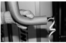
Schließlich richtet man den Dämmschlauch so aus, dass die Naht seitlich des Bogens im Verlauf der neutralen Faser liegt und schiebt ihn über den Rohrbogen
