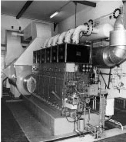
**... hierfür wird ein sechszylinderiger Spilling-Dampfmaschine als Gasexpansionsmaschine genutzt. Im Hintergrund ist der gekapselte Generator mit Zu- und Abluftkanal zu sehen**
