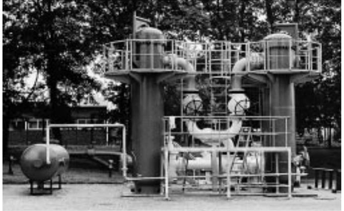
Bei einer Erdgasübergabestation wird der Leitungsdruck von z. B. 60 auf 6 bar reduziert. Die dabei frei werdende Energie nutzen die Stadtwerke Lübeck zur Stromerzeugung . . .
