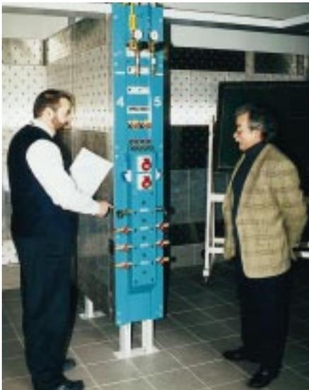
**In einer Säule vor der Trennwand von zwei Installationskabinen, in denen die Meisteranwärter ihre praktischen Fähigkeiten unter Beweis stellen, sind sämtliche Anschlüsse für Strom, Gas, Wasser sowie Azetylen und Sauerstoff untergebracht**
