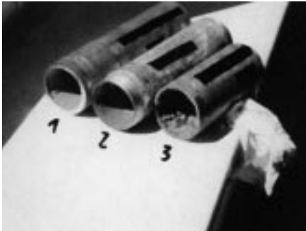
Die Rohrproben aus der Warmwasserversorgung (Probe 1 und 2) zeigten eine Auflösung der Zinkschicht, die aus der Kaltwasserleitung stammende dagegen Ausblühungen
